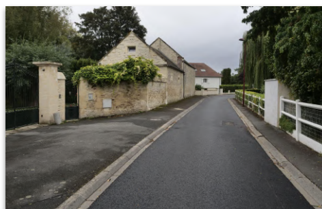
Septembre 2025 : rue Alberdi après la pose du nouvel enrobé
