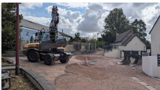
Août 2025 : venelle de l'église pendant les travaux d'entretien de voirie
