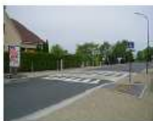
Des traversées piétonnes sur un plateau surélevé
