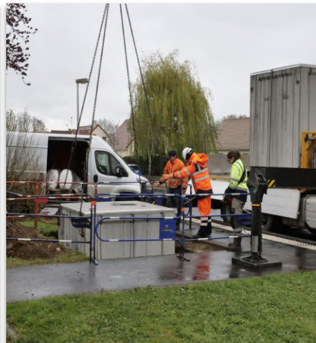
Travaux de mise en place du nouveau conteneur enfoui
