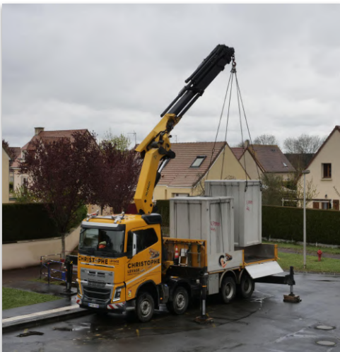
Travaux de mise en place du nouveau conteneur enfoui
